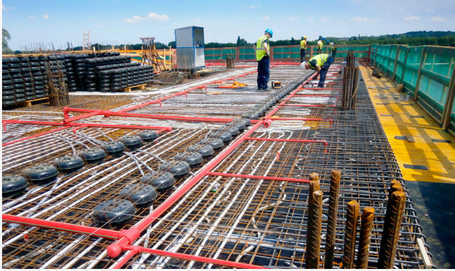
Ausrichten und Lagesicherung der ersten Hohlkörperreihe S120-140c (Quelle: Fritz Meyer GmbH)
