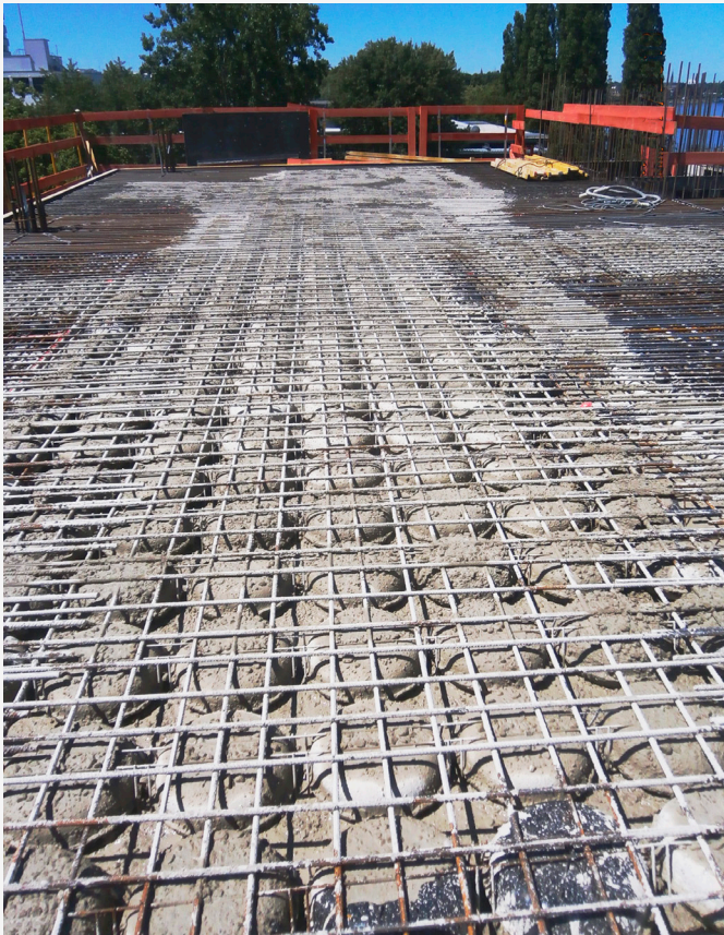
Hohlkörper im eingebauten Zustand / 1. Betonage (Quelle: Fritz Meyer GmbH)
