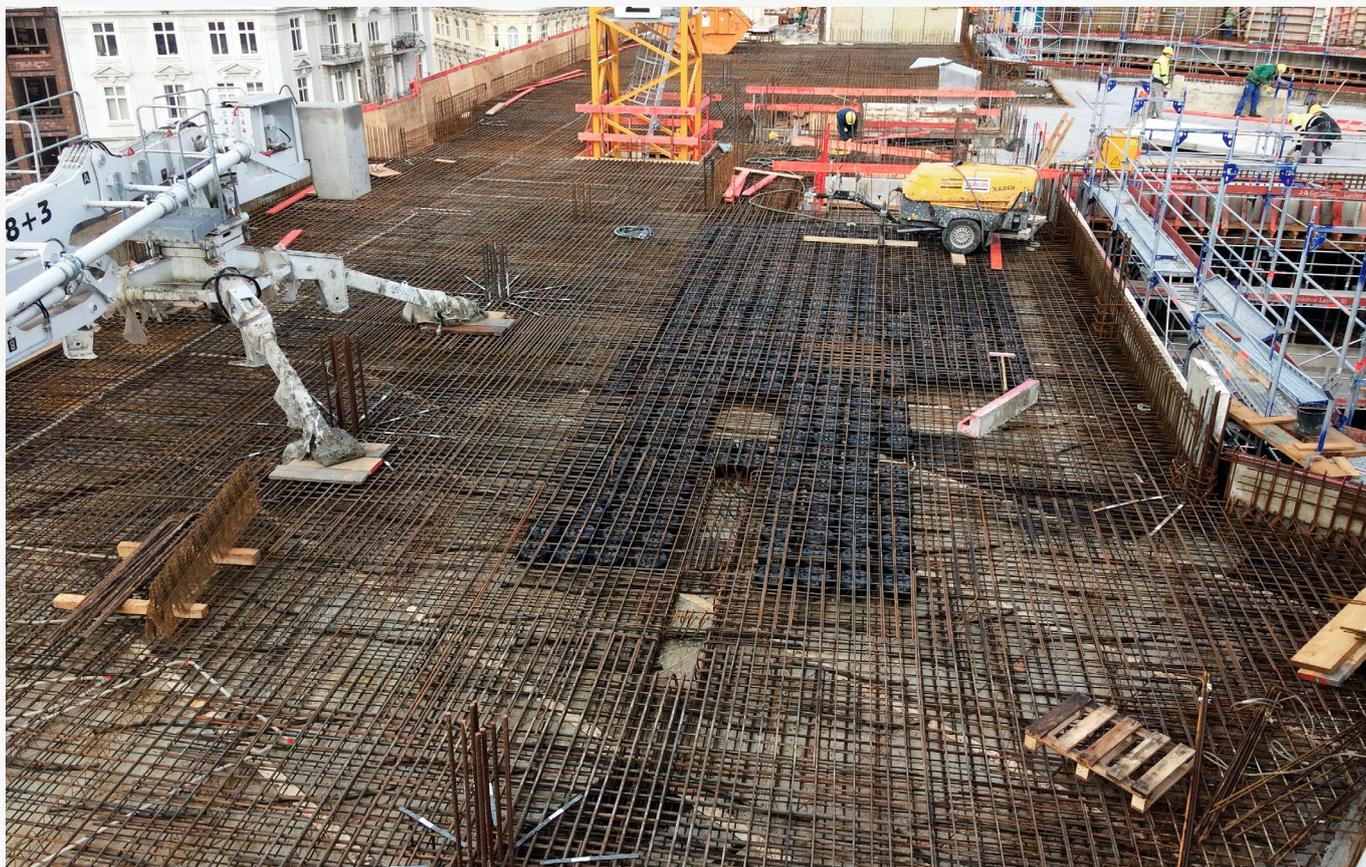
Etwa 50 Prozent der jeweiligen Deckenfläche wurden mit den SL-Hohlkörpersystemen von Cobiax ausgelegt, um die angestrebte Gewichtsreduzierung zu erzielen.
