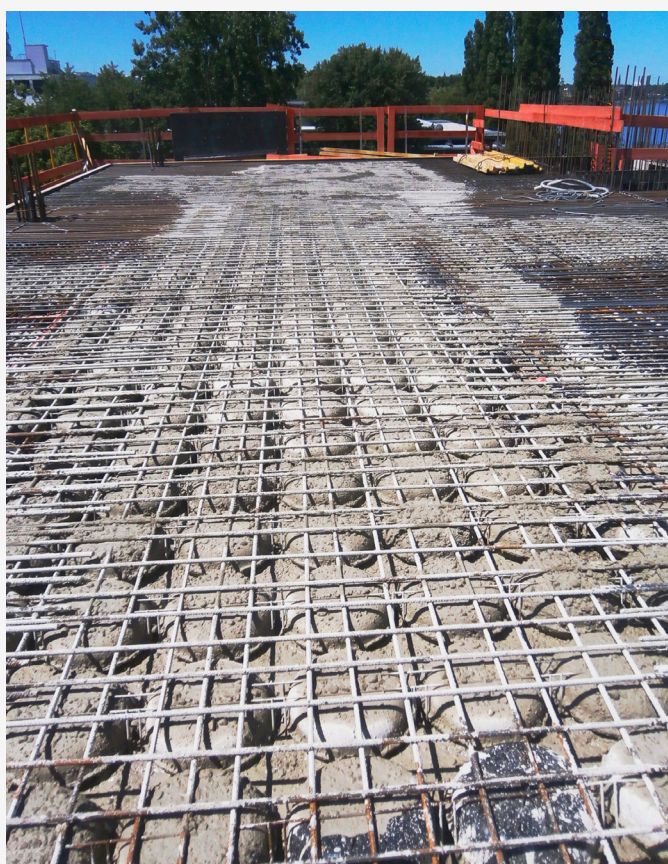
Corps creux à l'état installé / 1. Bétonnage (Source: Fritz Meyer GmbH)
