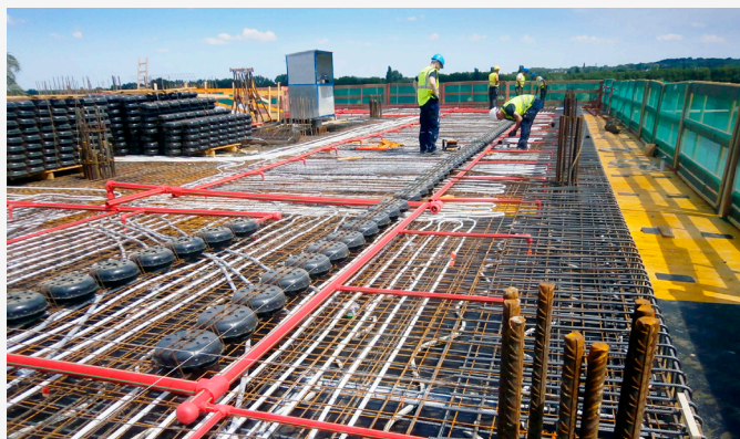
Aligner et fixer la première série de corps creux S120-140c (Source: Fritz Meyer GmbH)
