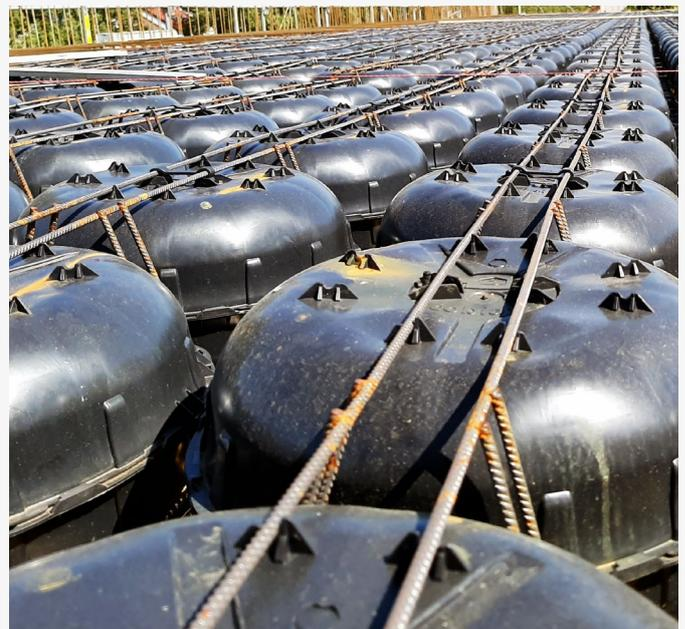
Durch die Verwendung von 34.398 Cobiax-Hohlkörpern konnten beim Ersatzneubau der Technischen Hochschule Ulm 1.210 Tonnen Beton eingespart werden. Quelle: Heinze Cobiax Deutschland GmbH
