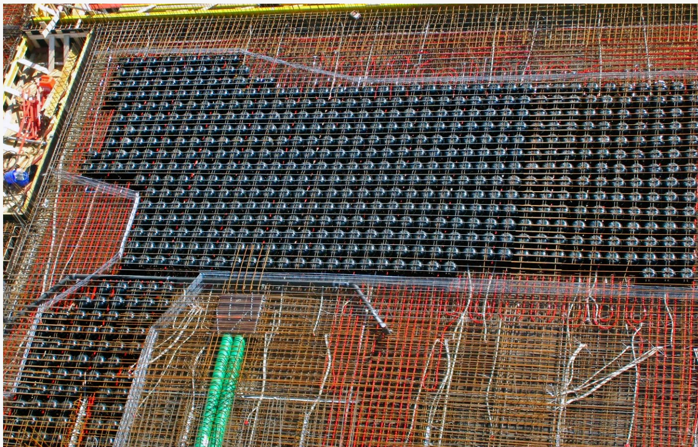
La coordinación de la planificación sin fisuras con todos los interesados fue particularmente importante, a fin de coordinar de antemano, por ejemplo, la colocación de los elementos de Cobiax y los conductos para la activación del núcleo de hormigón. Source: Leonhard Weiss GmbH & Co.KG
