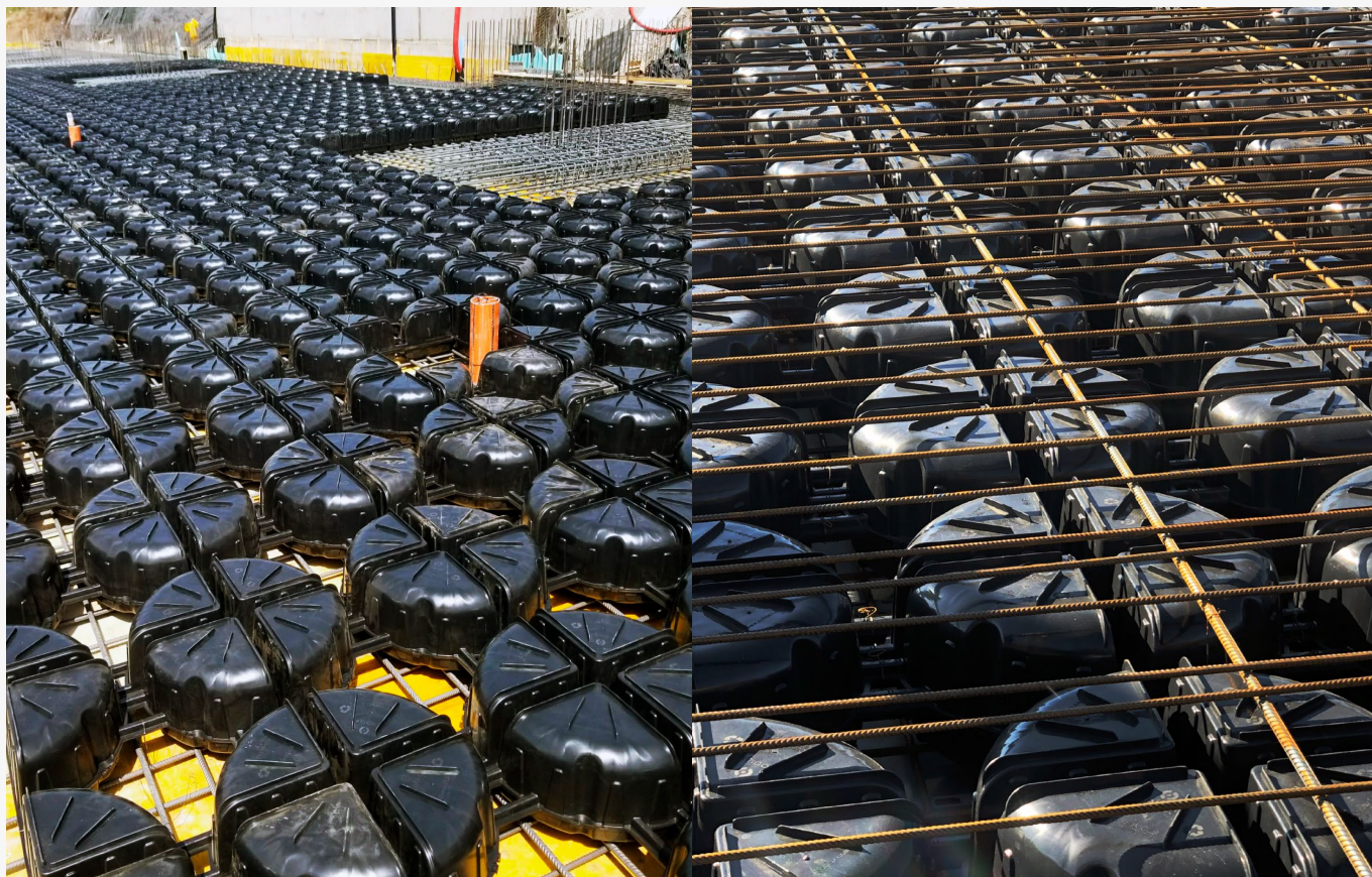
Bisher wurden bereits mehr als 14 Mio. m 2 Cobix-Hohlkörperdecken realisiert. Das entspricht einer Betoneinsparung von 2 Mio. Tonnen und einer CO 2 -Reduktion von 180.000 Tonnen. Bilder: © Heinze Cobix Deutschland GmbH
