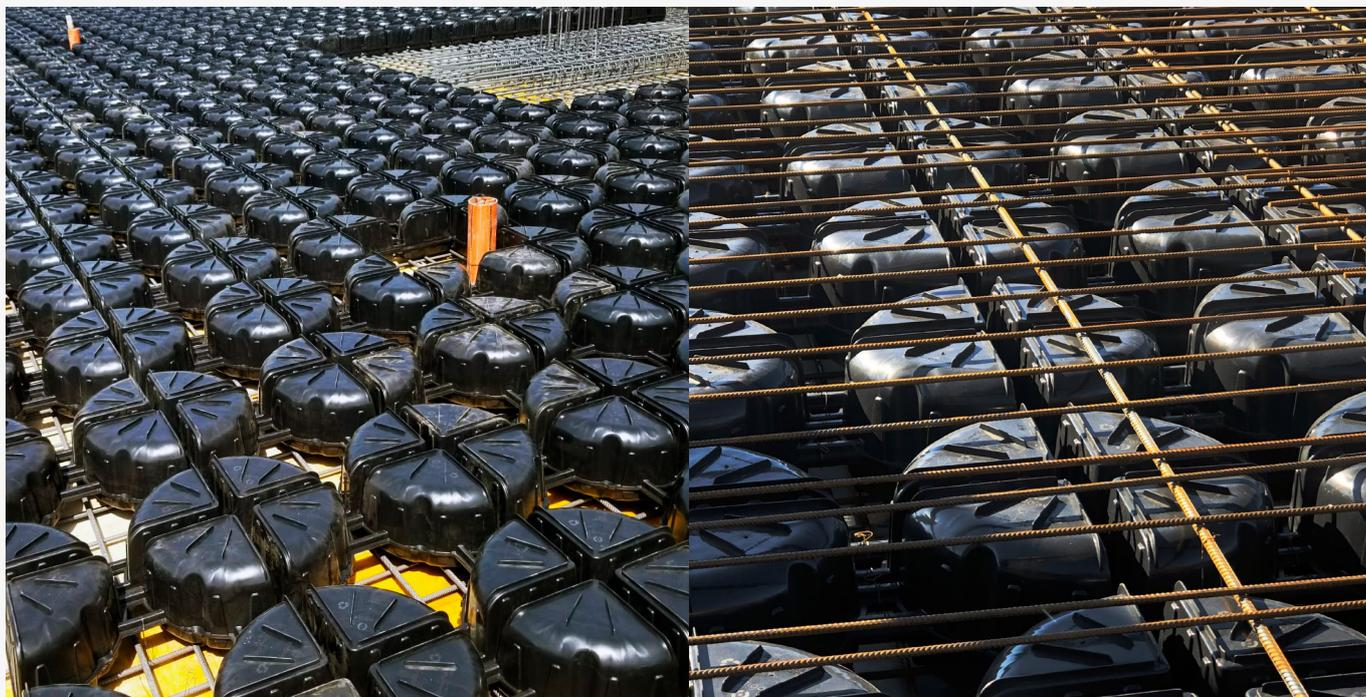
Jusqu'ici, plus de 14 millions de m<sup>2</sup> de dalles ont été construites en corps creux Cobiax de par le monde. Cela représente une réduction des besoins en béton de 2 millions de tonnes et une réduction d'émissions de CO<sub>2</sub> de 180.000 tonnes. Images : © Heinze Cobiax Deutschland GmbH
