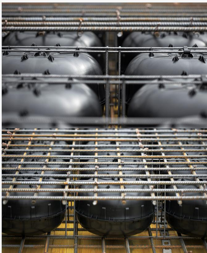
Les corps creux qui sont composés à 100% de matériaux plastiques recyclés (ici Cobiax SL) remplacent jusqu'à 35% du béton massif à l'intérieur des dalles en béton armé. (Source: Heinze Cobiax Deutschland GmbH)
