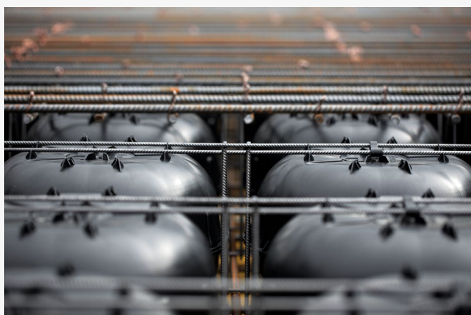
Modules Cobiax SL entièrement installés. Source: Heinze Cobiax Deutschland GmbH
