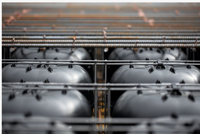
Plne nainštalované moduly Cobiax SL. Zdroj: Heinze Cobiax Deutschland GmbH
