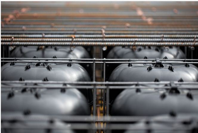
Fully installed Cobiax SL modules. Source: Heinze Cobiax Deutschland GmbH
