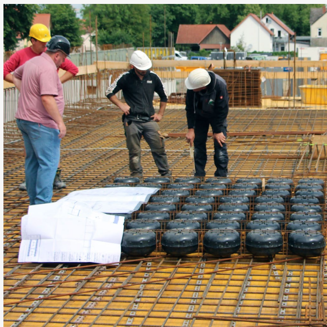
Réunion de construction : le plan de pose détaillés est mis en œuvre avec exactitude. Source: Aller-Weser-Klinik gGmbH.
