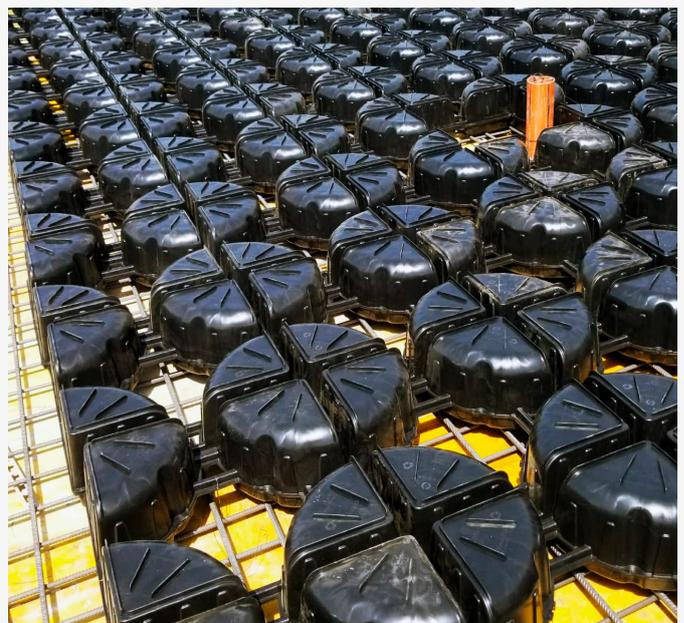
Los elementos se pueden alinear y conectar fácilmente para formar una estructura sólida. Source: Heinze Cobix Deutschland GmbH
