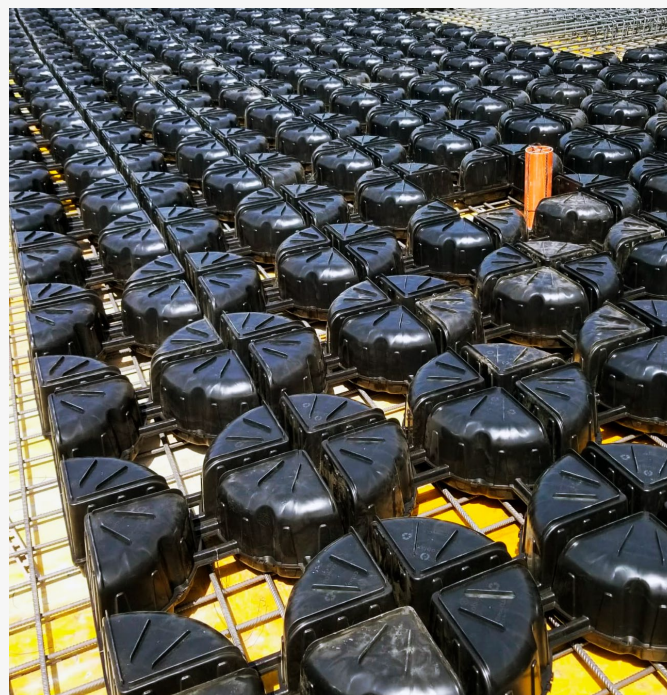
De elementen kunnen gemakkelijk op een rij worden gezet en met elkaar worden verbonden tot een stevige structuur. Bron: Heinze Cobiax Deutschland GmbH
