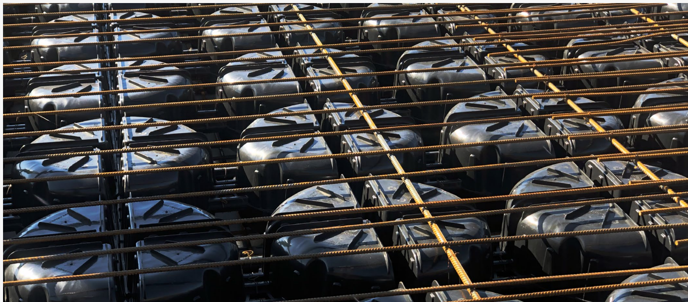
Verminderd gebruik van grondstoffen voor vloerplaten: Onze CLS-productlijn is ontworpen om niet alleen beton maar ook wapeningsstaal te besparen. Bron: Heinze Cobiax Deutschland GmbH
