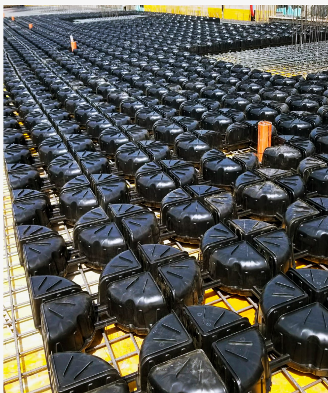
Prvky sa dajú ľahko spojiť a skladať, tak aby vytvorili pevnú štruktúru. Zdroj: Heinze Cobiax Deutschland GmbH
