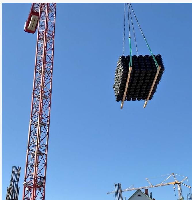
Aufgrund der variierenden Deckenstärken kommen verschiedene Varianten der Cobiax SL- und EL-Systeme zum Einsatz, die teils vormontiert und teils in Komponenten für den Zusammenbau an der Baustelle geliefert werden.
