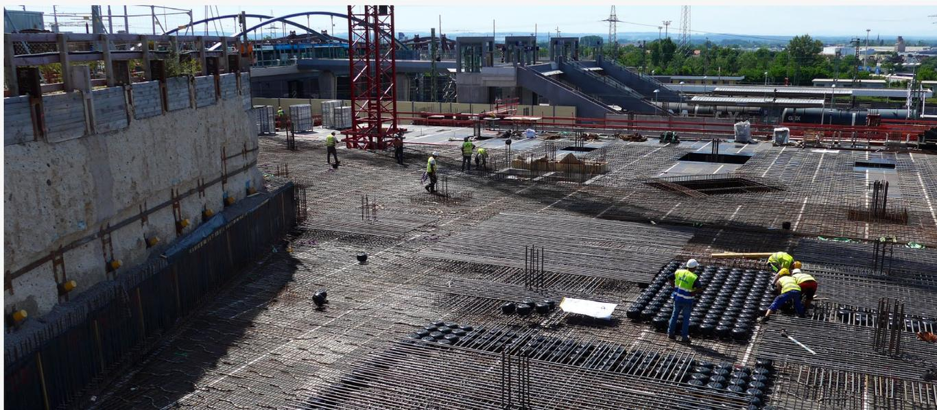
Circa 108.000 Hohlkörper werden in genau vordefinierten, statisch nicht relevanten Bereichen verwendet, sodass sich eine Gesamt-Hohlkörper-Deckenfläche von etwa 35.000 m<sup>2</sup> ergibt. Quelle: CEMAGG Weil am Rhein GmbH & Co. KG
