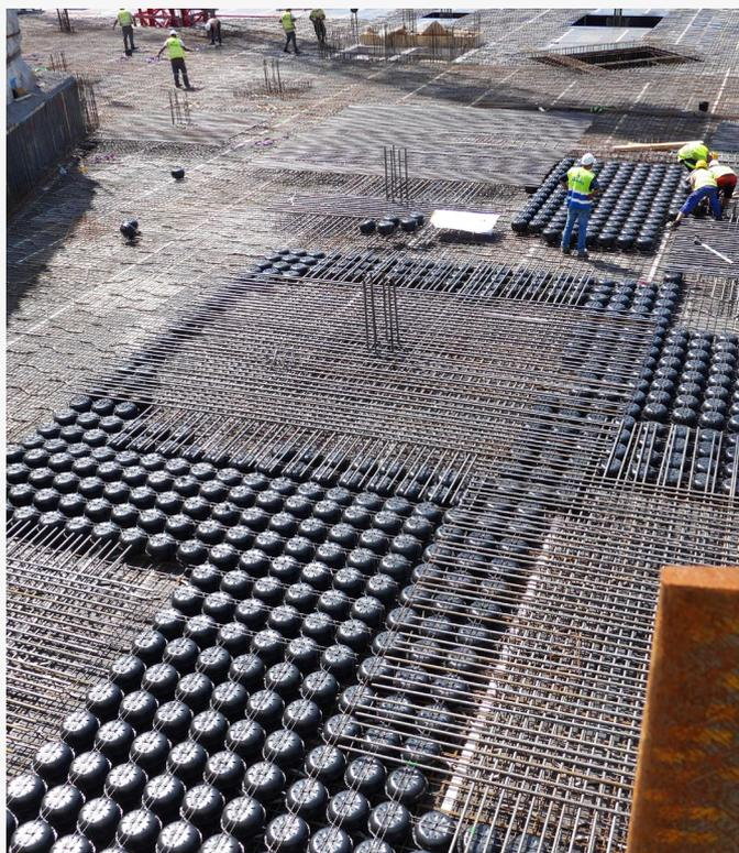
Um das Gewicht der Gebäude trotz einer Erweiterung konstant zu halten, kommen Hohlkörperelemente von Cobiax zum Einsatz.
