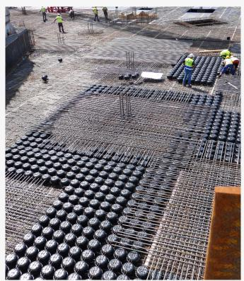
Afin de ne pas excéder le poids des bâtiments en dépit d'une extension, des éléments à cours creux Cobiax sont utilisés.
