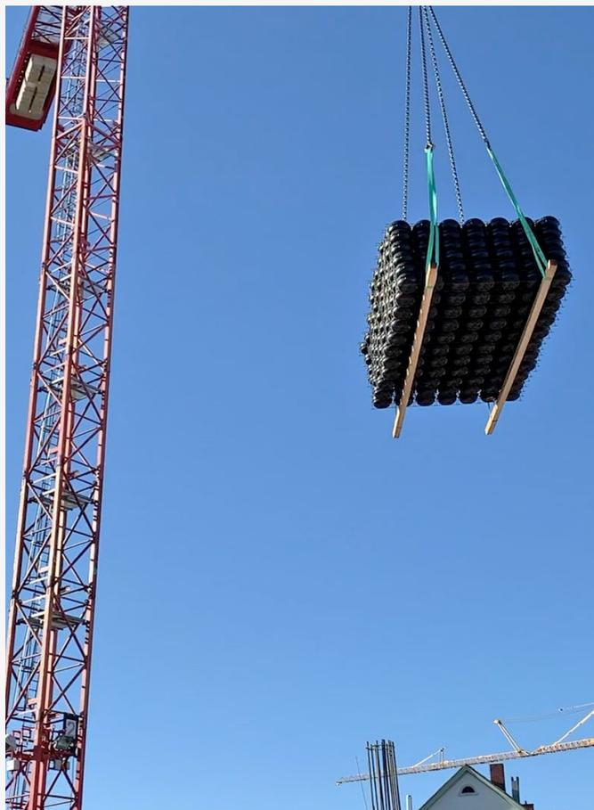
Debido a los diferentes espesores de techo, se utilizan diferentes versiones de los sistemas Cobiax SL y EL, algunos de los cuales están premontados y otros se suministran en componentes para su montaje en la obra.
