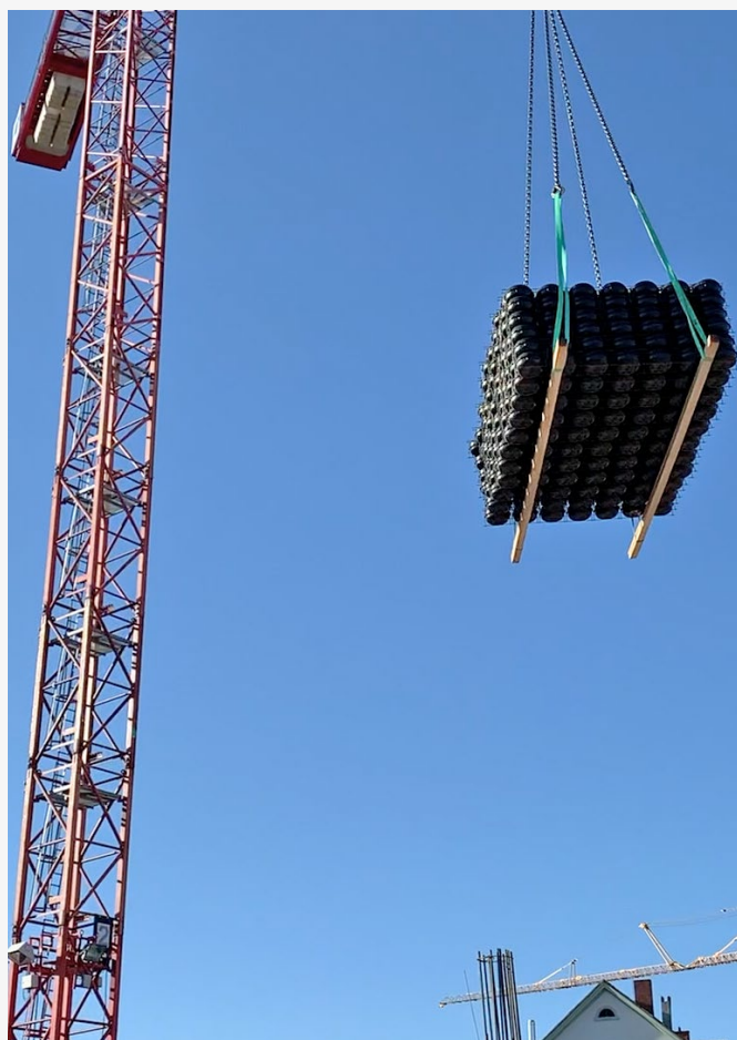
Kvôli rôznej hrúbke stropu sa používajú rôzne verzie systémov Cobiax SL a EL. Niektoré sú dodávané už predmontované, a niektoré sú dodávané v komponentoch určených na zloženie na stavbe. Zdroj: Heinze Cobiax Deutschland GmbH
