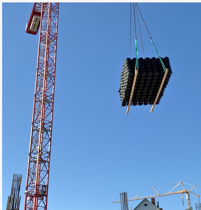
Vanwege de verschillende plaatdiktes worden verschillende varianten van de Cobiax SL en EL systemen gebruikt, waarvan sommige voorgemonteerd worden geleverd en andere in onderdelen voor montage ter plaatse. Bron: Heinze Cobiax Deutschland GmbH
