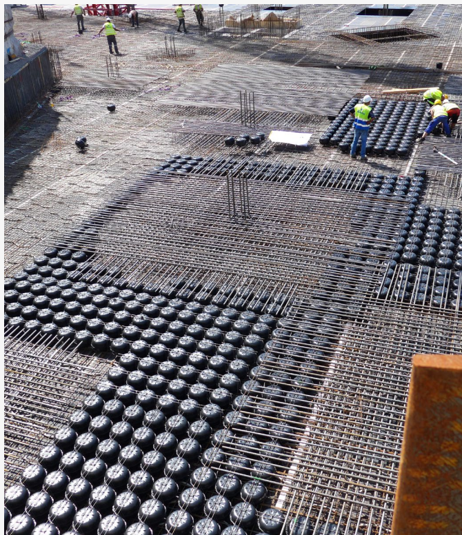
Om het gewicht van de gebouwen ondanks een uitbreiding constant te houden, worden holtevormer elementen van Cobiax gebruikt. Bron: CEMAGG Weil am Rhein GmbH & Co. KG
