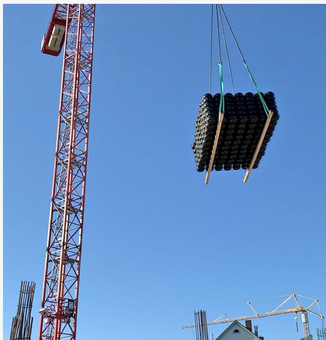
A causa dei diversi spessori delle solette, vengono utilizzate diverse varianti dei sistemi Cobiax SL e EL, alcune delle quali vengono fornite preassemblate e altre in forma di componenti da assemblare in loco.
