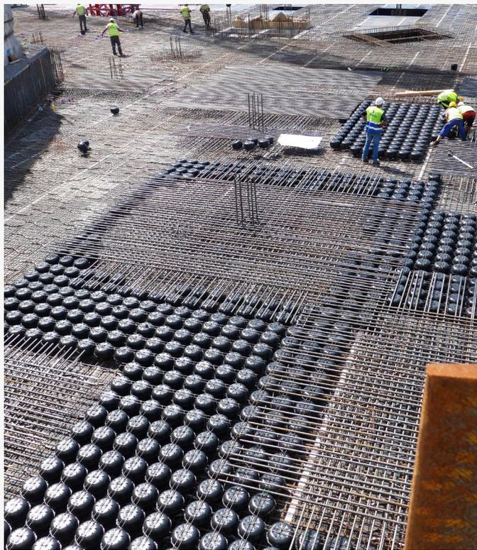
Per mantenere il peso degli edifici costante, nonostante la sopraelevazione, vengono utilizzati elementi cavi di Cobiax.
