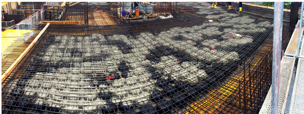
Una costruenda soletta Cobiax SL durante il getto di prima fase.
