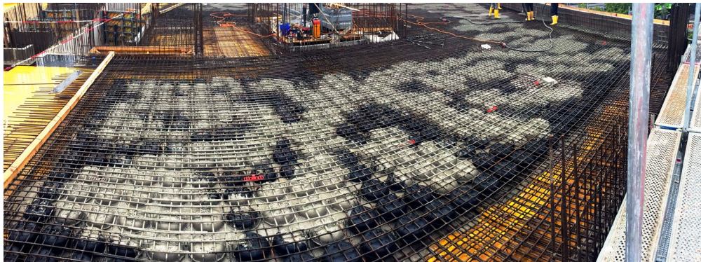
Budúci vylahčený železobetónový strop Cobiax SL počas prvej etapy betónáže.
