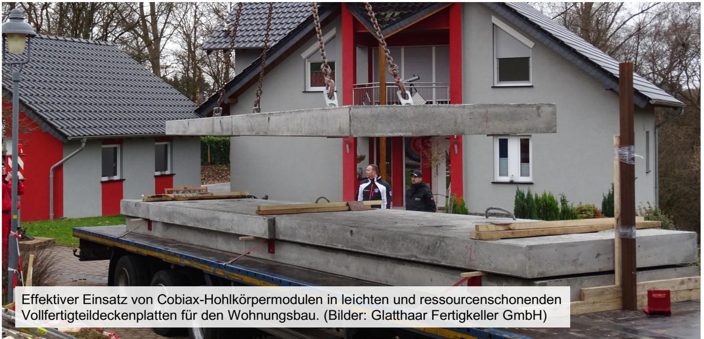
Effektiver Einsatz von Cobiax-Hohlkörpermodulen in leichten und ressourcenschonenden Vollfertigteildeckenplatten für den Wohnungsbau. (Bilder: Glatthaar Fertiggeller GmbH)
