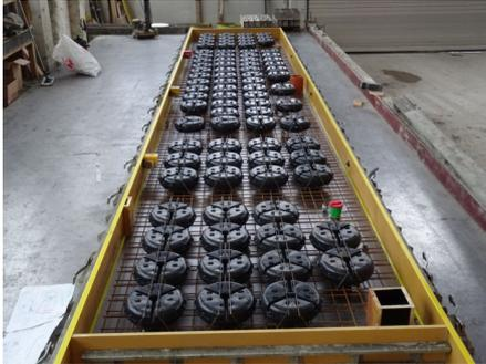
Die Module wurden nach Erfordernis flexibel gekürzt und partiell mittels Bindedraht gegen verschieben mit der Bewehrung verbunden. Nachfolgend erfolgte der Einbau der Randbewehrung sowie der oberen Bewehrungslage. Die Cobiax-Hohlkörpermodule dienen hierbei gleichzeitig als Unterstützungselement.
