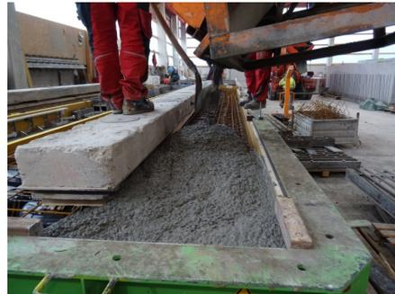
Nach dem Entfernen der Auflast wurden die nicht betonierten Bereiche verfüllt, nachverdichtet und die gesamte Oberfläche geglättet.
