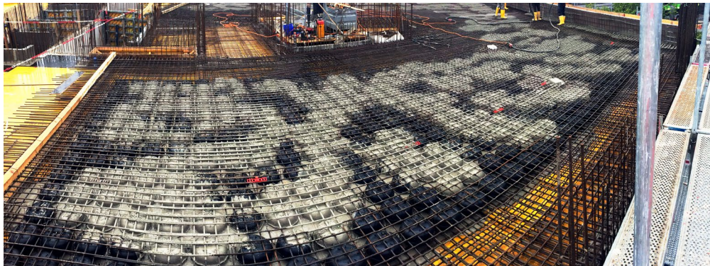
Une dalle en béton armé Cobiax SL en cours de construction lors du premier bétonnage.
