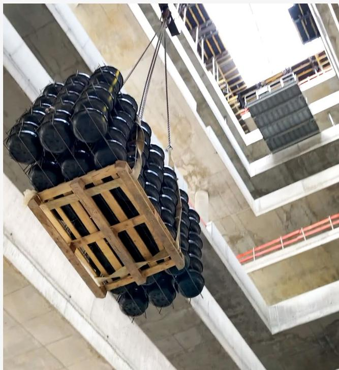
Die Hohlkörpermodule werden mit einem Kran auf der Geschossdecke abgesetzt und per Hand exakt verlegt. Dank ihres niedrigen Gewichtes sind für diese Tätigkeit nur zwei Personen nötig.
