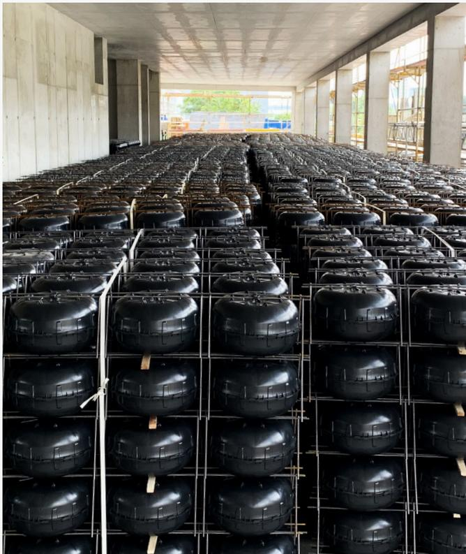
Praktisch bei begrenzten Lagerflächen: Cobiax-Hohlkörper des Typs „Cobiax SL“ werden in Einzelteilen angeliefert und lassen sich vor Ort einfach zu Modulriegeln zusammensetzen.
