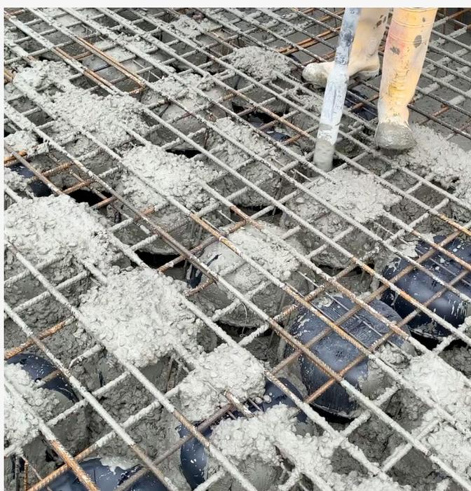
Betonieren in zwei Schritten: Zuerst wird die untere Bewehrungslage, an der die Hohlkörpermodule befestigt sind, einbetoniert. Dann wird die Betonage der Decke vervollständigt. Quelle: Cobiax, Bielefeld.
