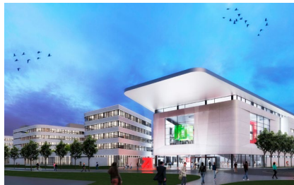
ProSieben Sat1 New Campus, Unterföhring
