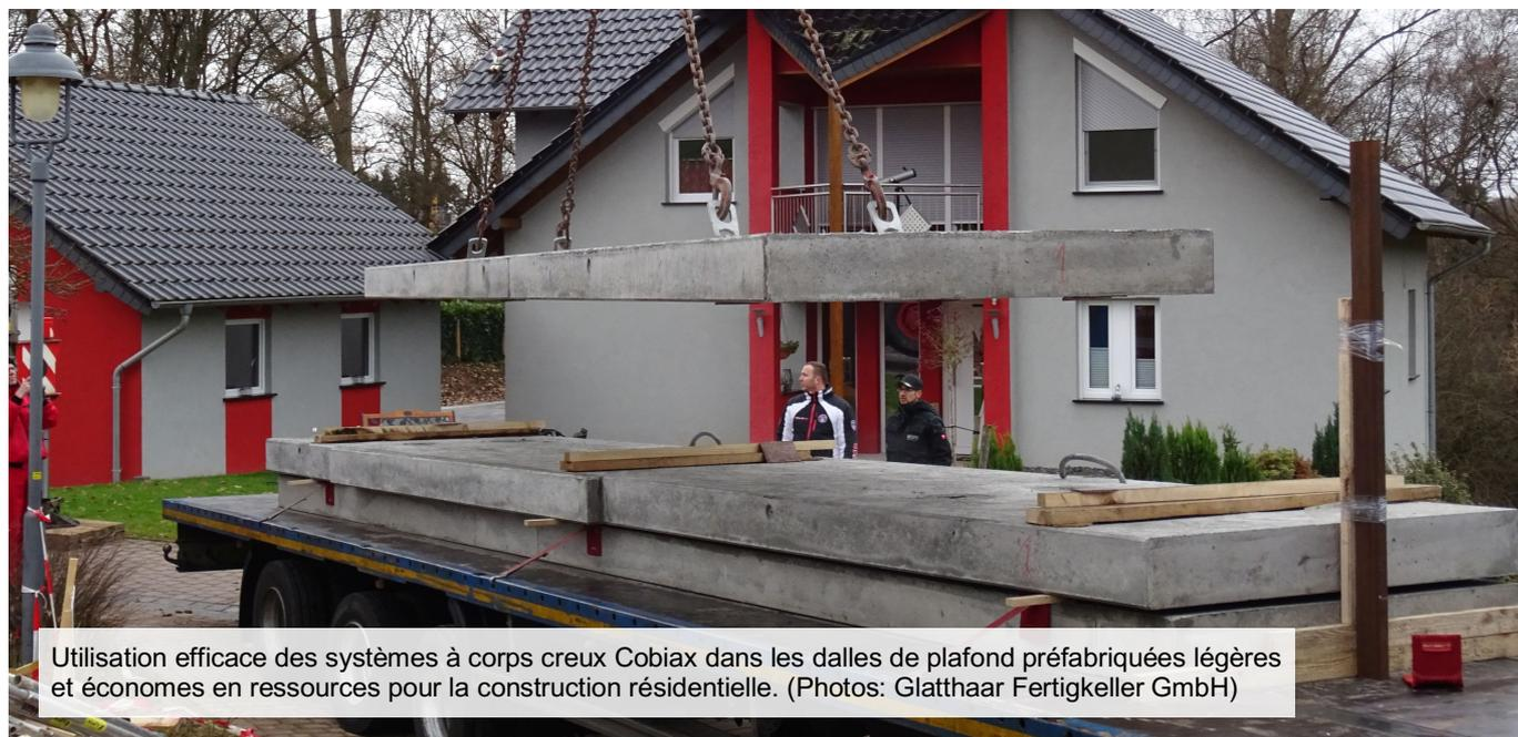
Utilisation efficace des systèmes à corps creux Cobi<sup>ax</sup> dans les dalles de plafond préfabriquées légères et économes en ressources pour la construction résidentielle. (Photos: Glatthaar Fertiggeller GmbH)
