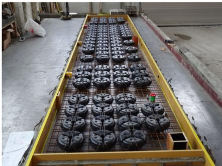
Les modules ont été raccourcis de manière flexible selon les besoins et partiellement reliés à l'armature au moyen d'un fil de liaison contre le déplacement. Par la suite, le renforcement des bords et la couche de renforcement supérieure ont été installés. Les systèmes à corps creux Cobiax servent également d'éléments de support.
