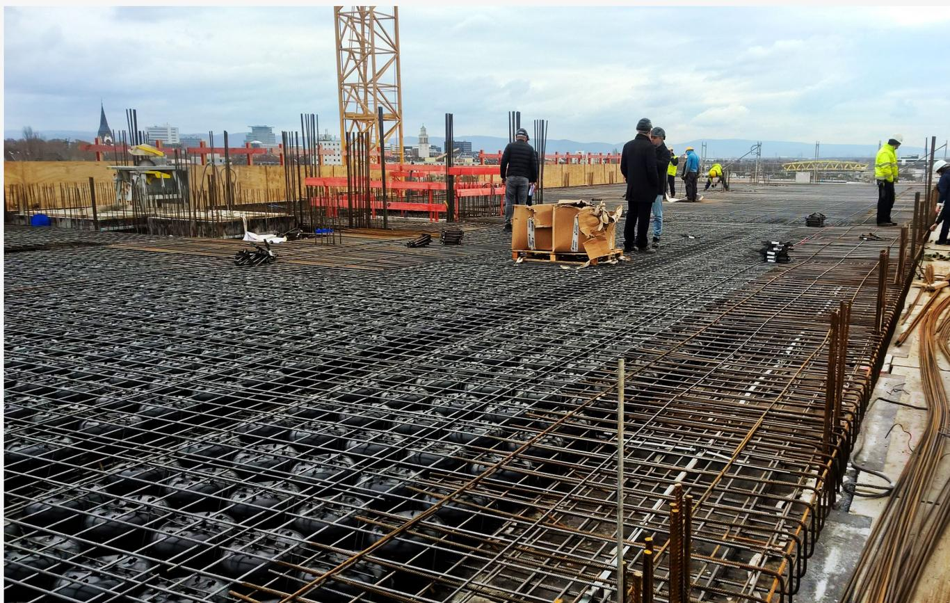
Dans le cas d'un pré-bétonnage, les éléments sont fixés afin d'éviter toute flottabilité. L'adhérence se fait ici par le biais des éléments en acier d'armature des modules de corps creux qui servent également de fixation pour chaque corps creux.
