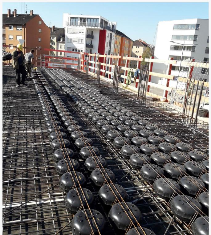
Der Einsatz der Cobiax-Technologie ermöglicht deutliche Einsparungen bei Material und Gewicht, so dass geringere Deckenstärken und Spannweiten von bis zu 20 m realisiert werden können.
